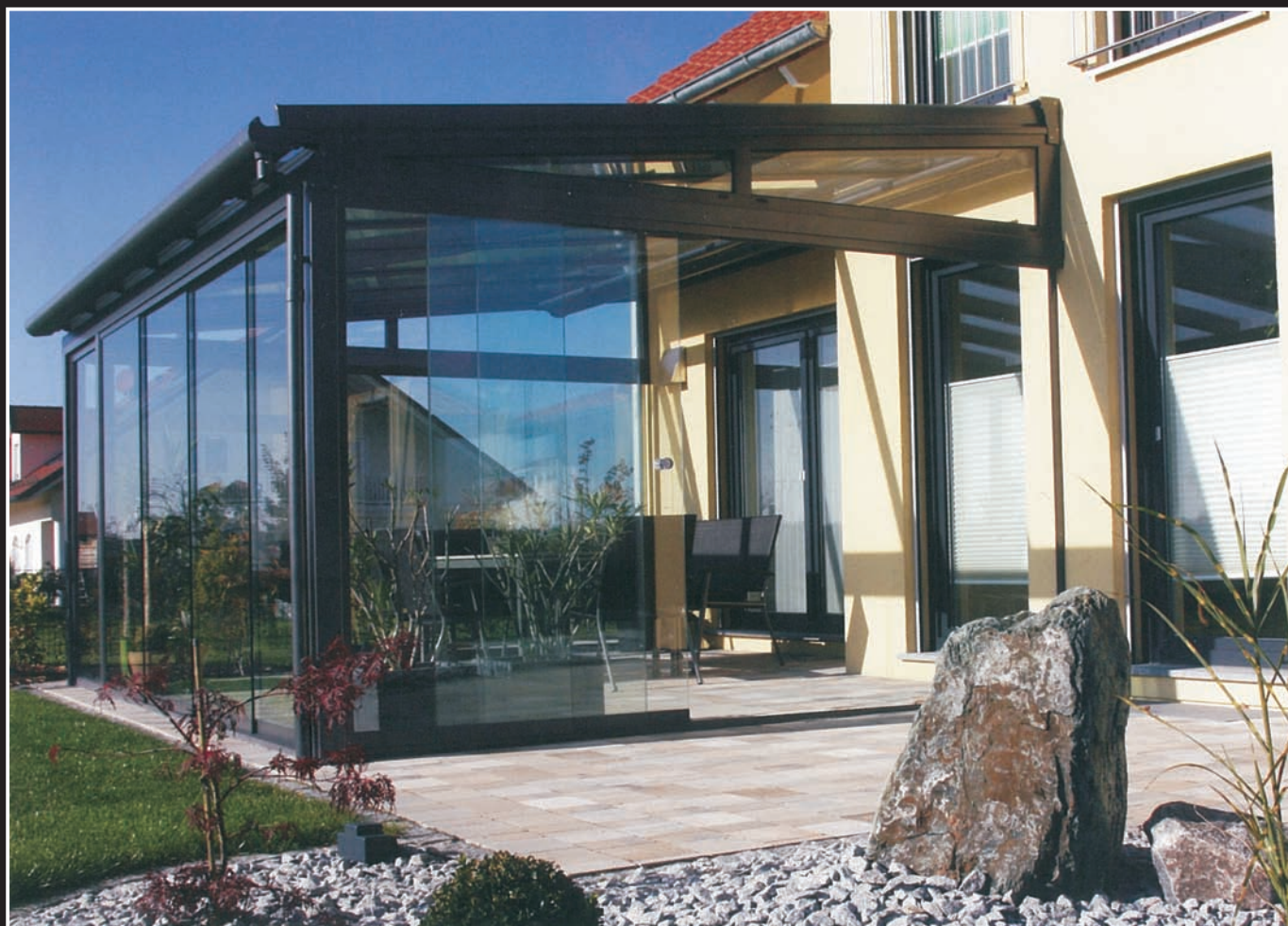
hliníkové zastřešení terasy včetně bočních posuvných stěn
